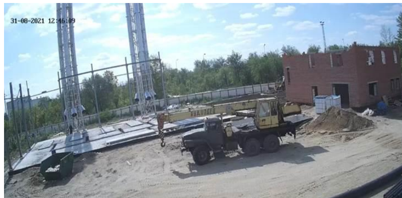
Строительство котельной мощностью 60МВт для посёлка Энергетиков
