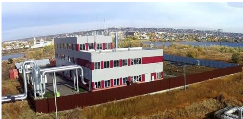
Котельная для центральной части города Троицка (мощностью 120 МВт)
